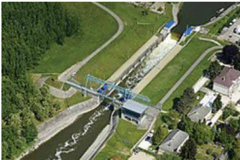
12. kép: A Tassi-zsilip felülnézetből
